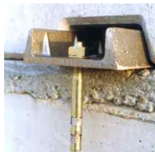
Fissaggio a pavimento e Bulloni d'angoraggio
